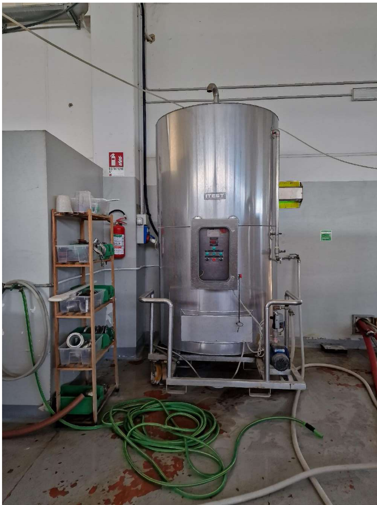
34- SERBATOIO SU CARRELLO MARCA ITEST L 2000
